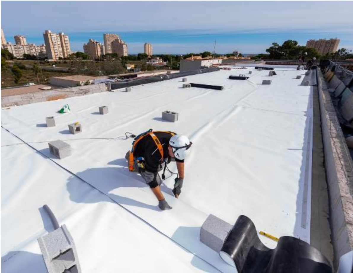
Liceo Francés (Alicante) – Cubierta lastrada
