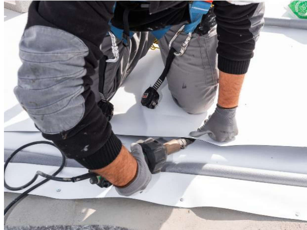
Termosoldado de la lámina en la zona de solape
