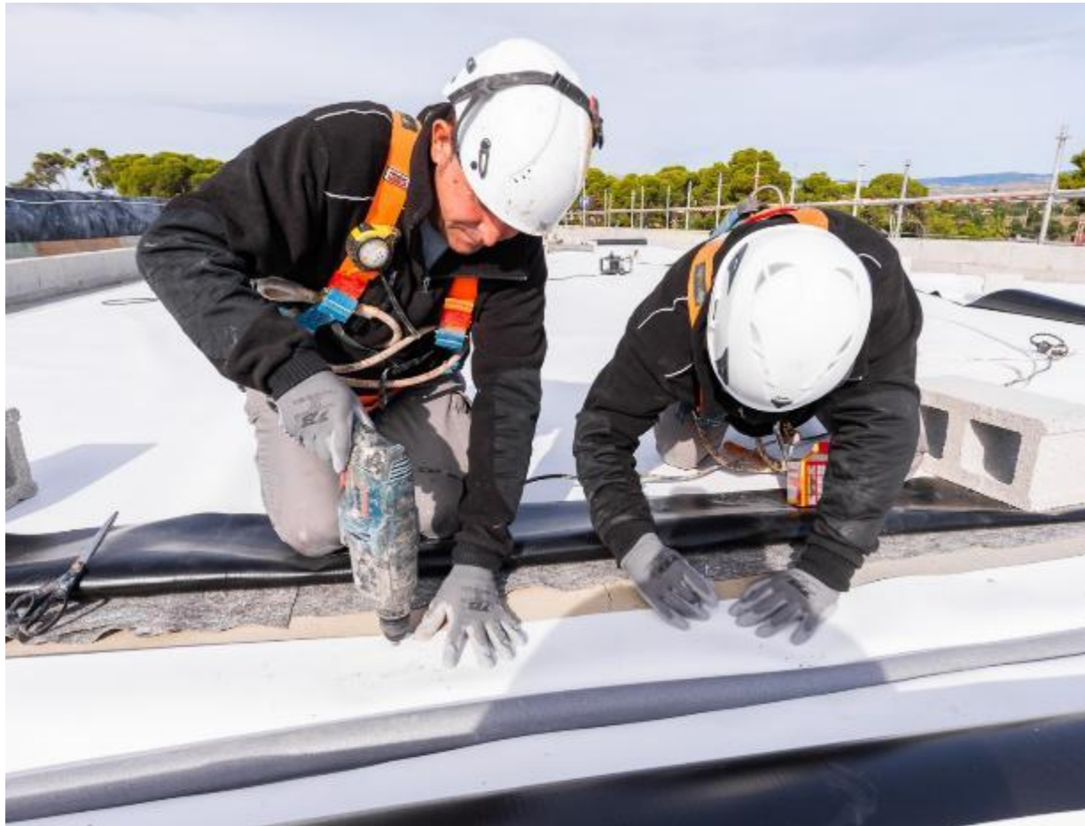
Fijación mecánica con tornillo autotaladrante
