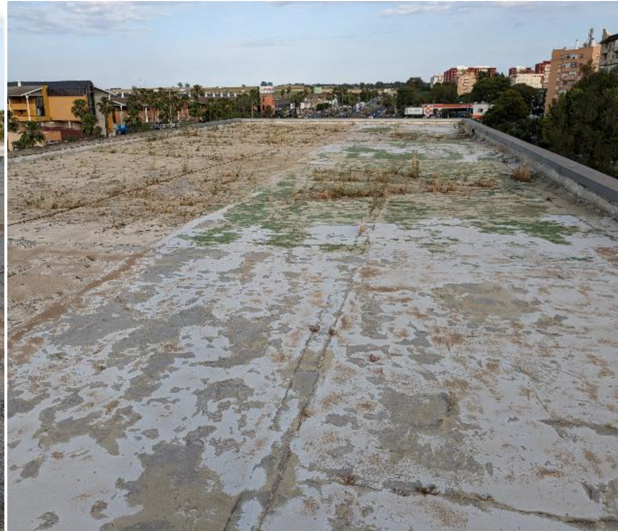
Cubierta impermeabilizada con tela asfáltica
